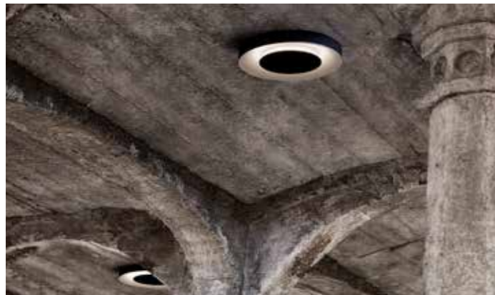
Soffitto, Ceiling, Decken - P. 14
